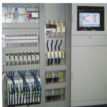
▼ 121.2 kW, 88 區, 基於PC的開環控制系統
